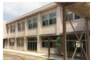
耐震化改修後の附属岡崎中学校給食室
