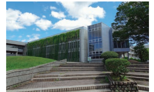
第一共通棟 (現在)
