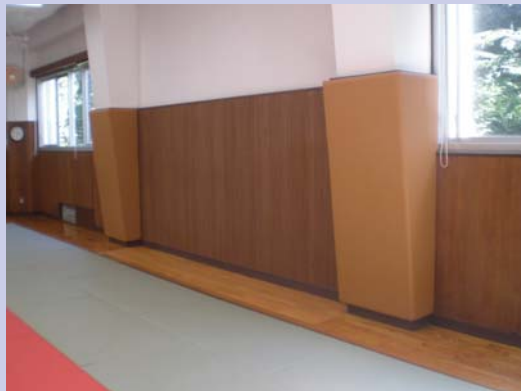
ウレタン防護マットによる安全対策
