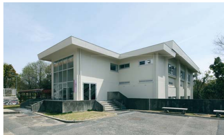
武道場 改修後
