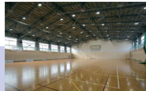
After LED照明採用 落下防止対策 老朽改善
