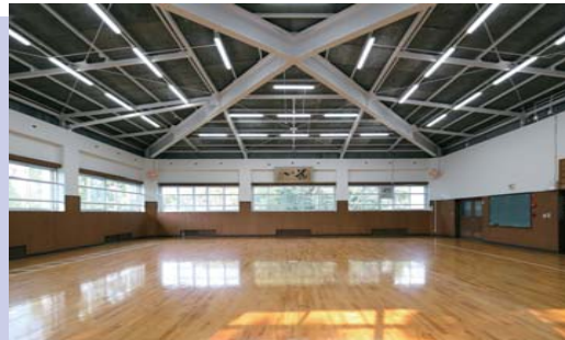
2階剣道場 LED照明採用 落下防止対策 老朽改善
