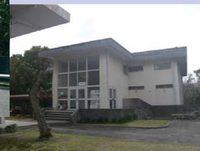
武道場 改修前
