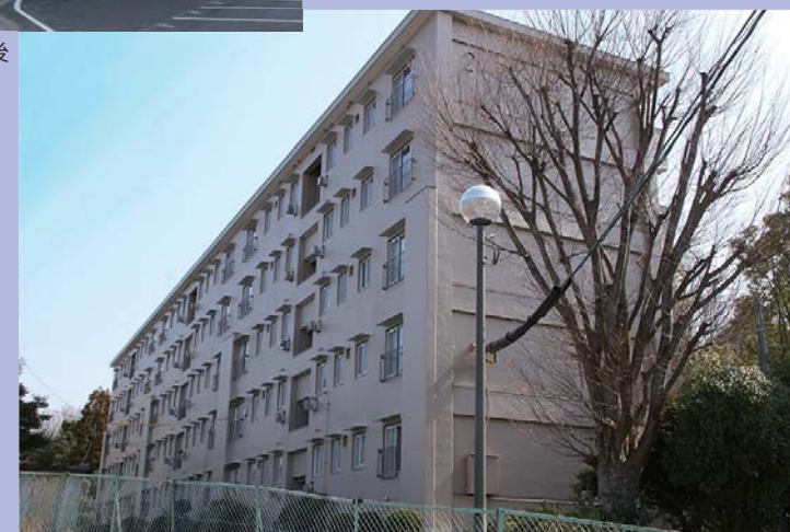
井ヶ谷住宅2号棟 改修後
