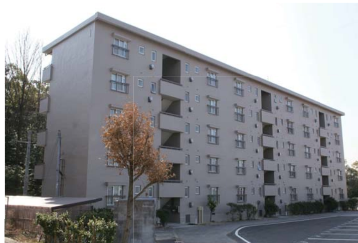
井ヶ谷住宅1号棟 改修後
